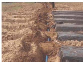
Instalación del sistema de riego localizado
