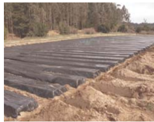
Platabandas terminadas y en condiciones para comenzar la plantación
